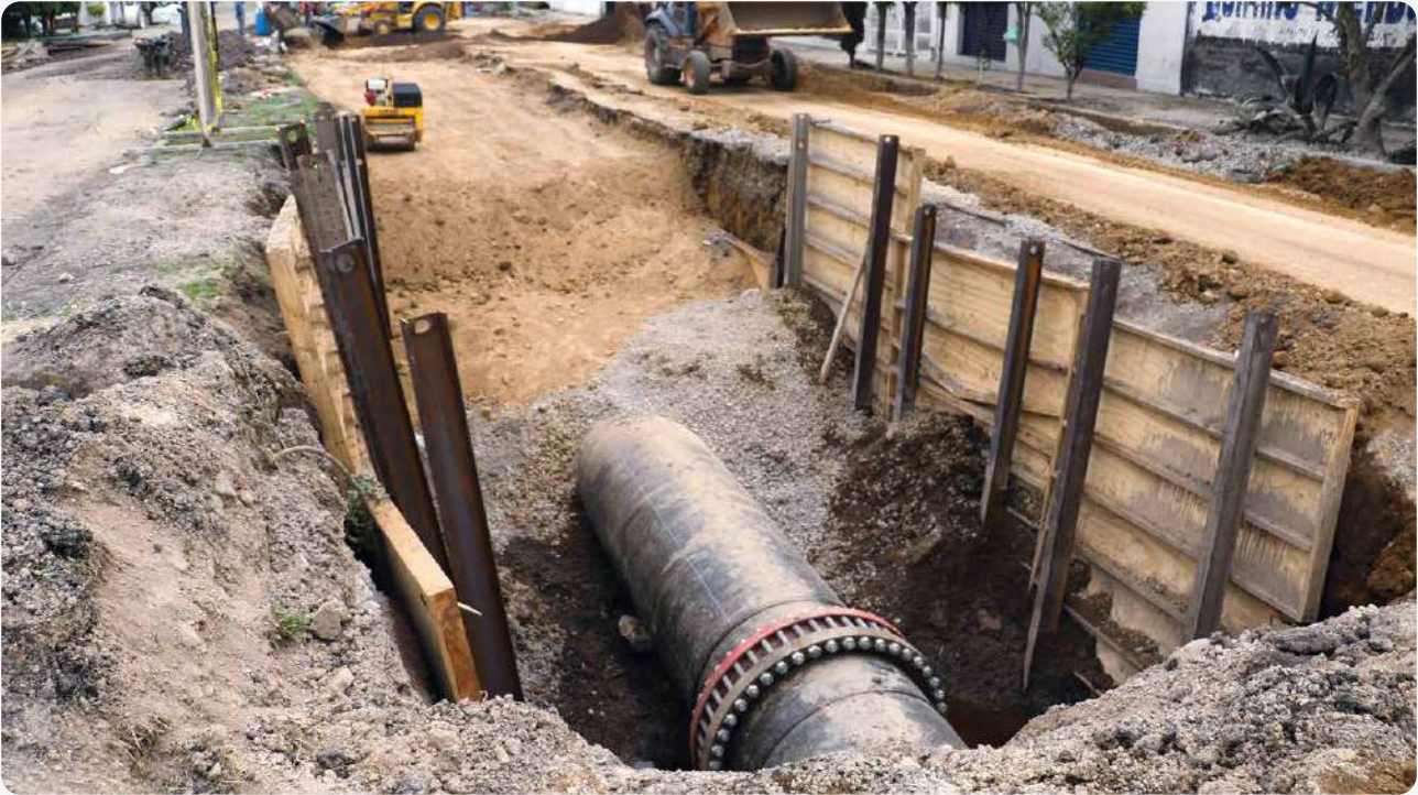
Figura 33. Rehabilitación de tubería.
