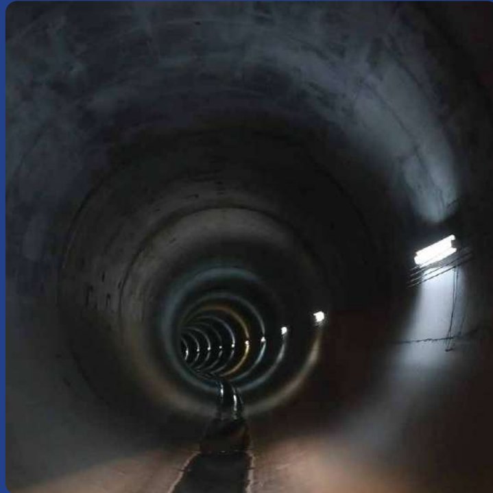
Figura 30. Túnel Emisor Oriente (TEO).
