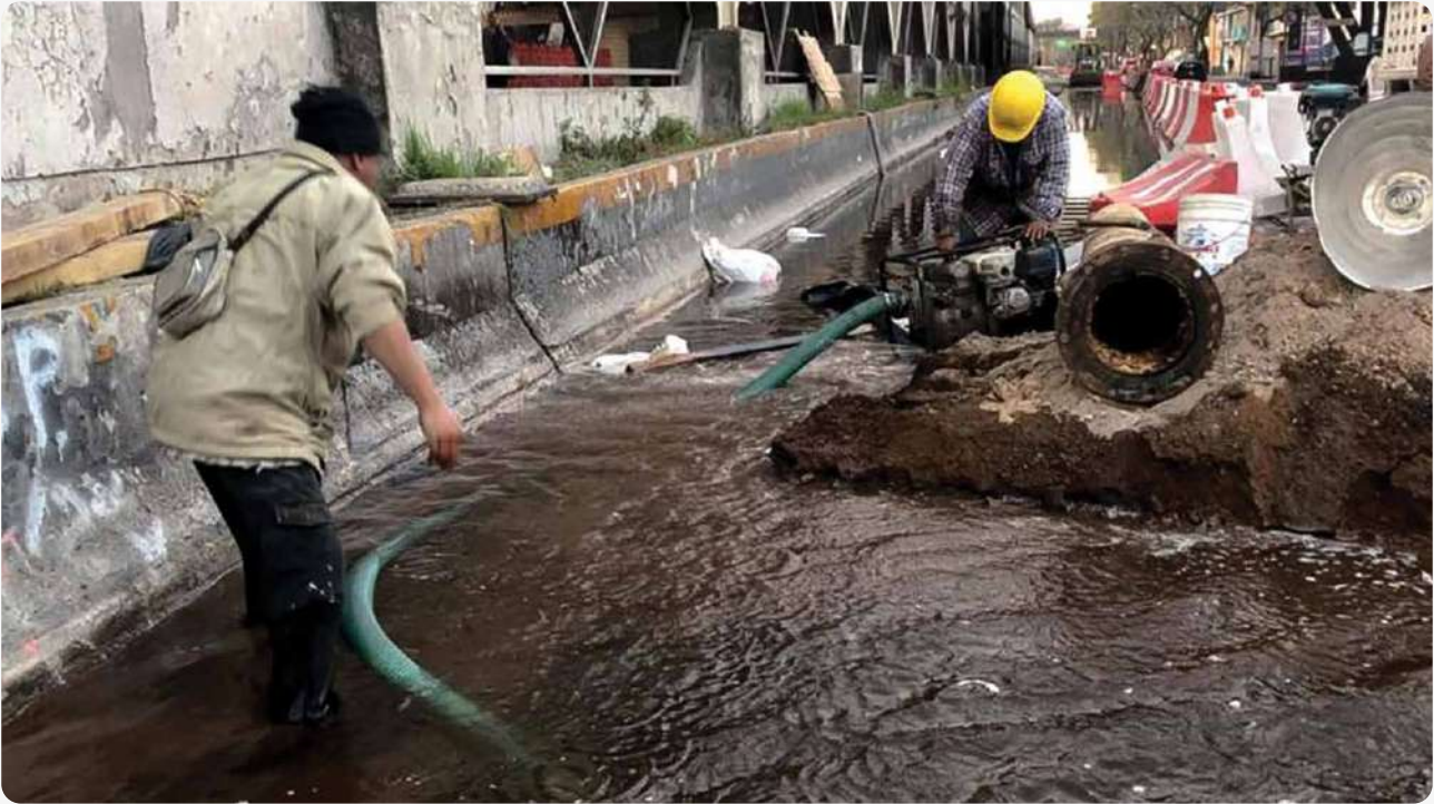
Figura 31. Fugas en el Valle de México.
